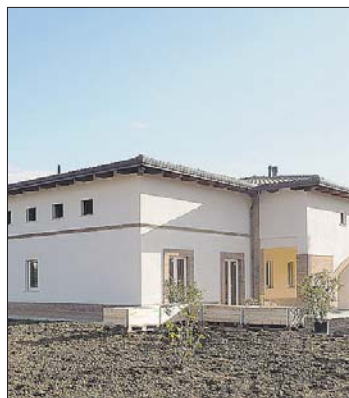
Aiuti da tutti In tanti hanno contribuito alla realizzazione della struttura
